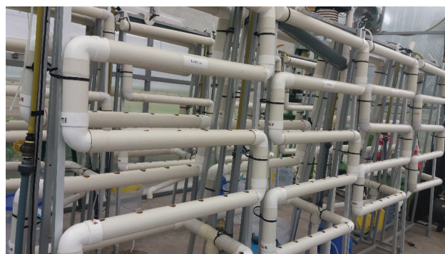
Figura 4. Instalación del sistema hidropónico.
