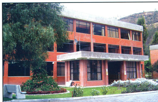
Edificio 3. En este funcionan las Escuelas ECAA, Sistemas, Diseño y ELL.
