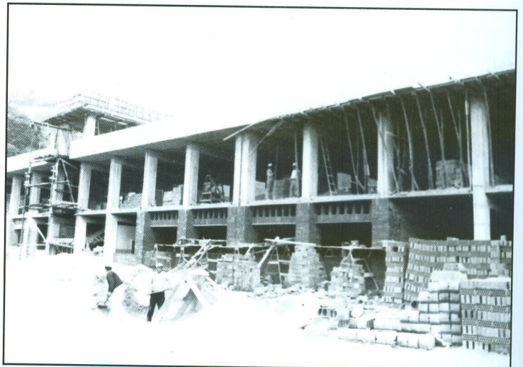
Construcción Edificio N 1 en el año de 1984.
